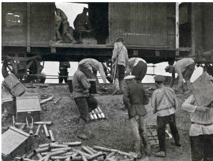
Krievijas armijas karavīri dzelzceļa vagonu izkraušanas darbos Ļaojanas stacijā. 1904. gada augusts.
